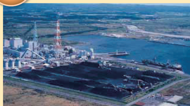
苫東厚真発電所(北海道勇払郡厚真町)
