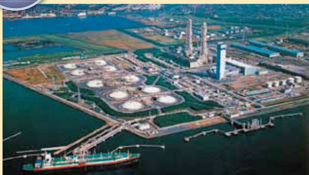
富津火力発電所(千葉県富津市)
