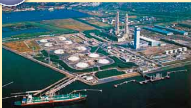
富津火力発電所(千葉県富津市)
