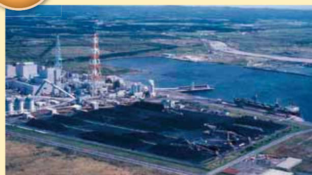
苫東厚真発電所(北海道勇払郡厚真町)
