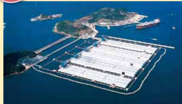
上五島石油備蓄基地(長崎県南松浦郡新上五島町)
