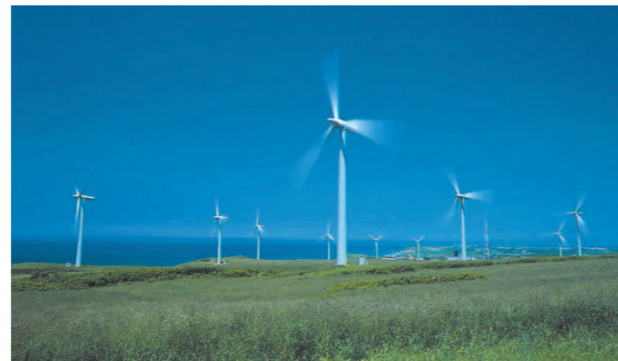
苫前風力発電所(北海道苫前郡苫前町)
