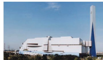
新江東清掃工場(東京都江東区) (写真:東京二十三区清掃一部事務組合)
