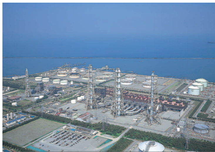
東新潟火力発電所(新潟県北蒲原郡聖籠町)
