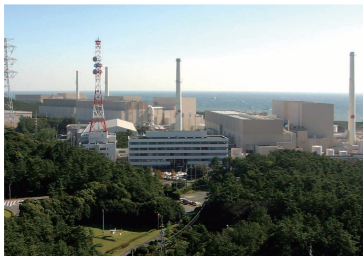
浜岡原子力発電所(静岡県御前崎市)
